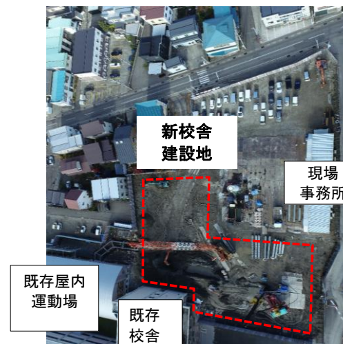
工事状況（令和6年11月25日撮影）
