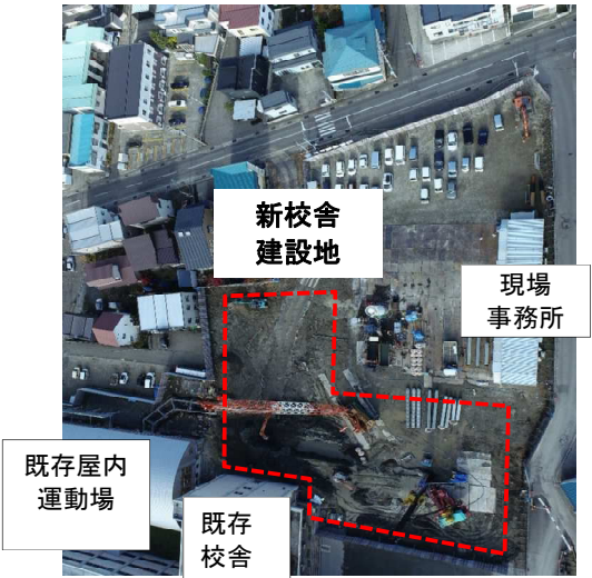
工事状況 (令和6年11月25日撮影)
