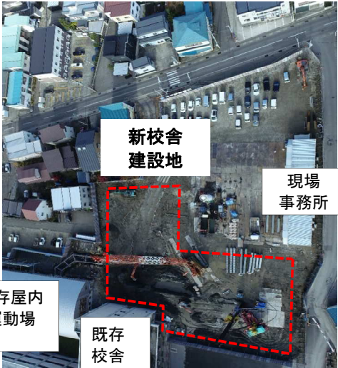
工事状況(令和6年11月25日撮影)
