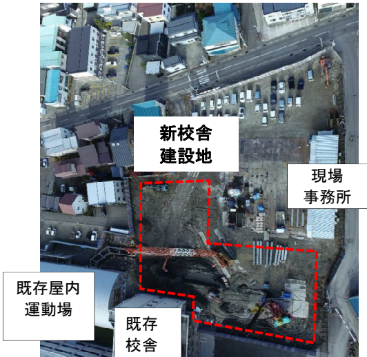
工事状況 (令和6年11月25日撮影)
