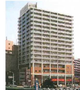
①青森駅前第一地区 （平成18年竣工）
