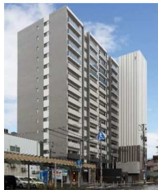
⑤古川一丁目12番地区 （平成29年竣工）
