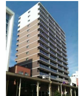
④中新町センター地区 （平成26年竣工）
