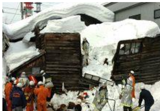
図 54 雪の重みで倒壊した家屋
