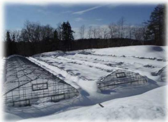
雪の重みで倒壊したパイプハウス
