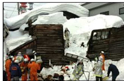
【雪の重みで倒壊した家屋】
