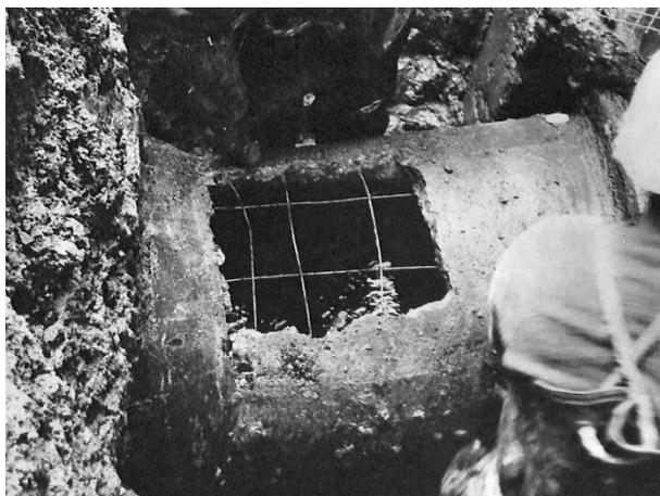
十勝沖地震<sup>\*</sup>による導水管<sup>\*</sup>の破損
