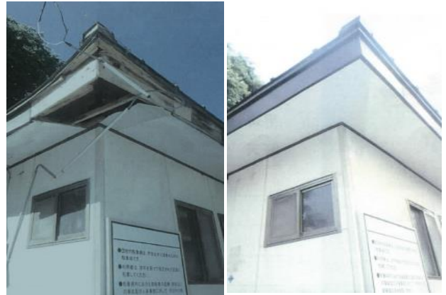
写真（左：修繕前 右：修繕後）
