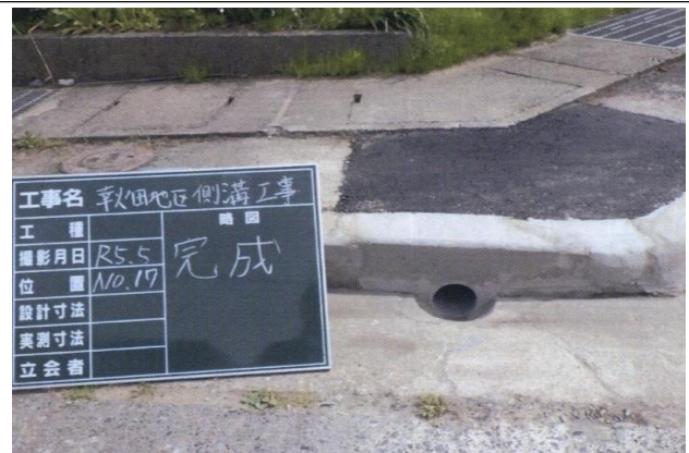
補修工事後の写真
