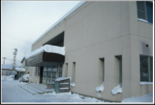
⑩から撮影した写真（敷地内）
