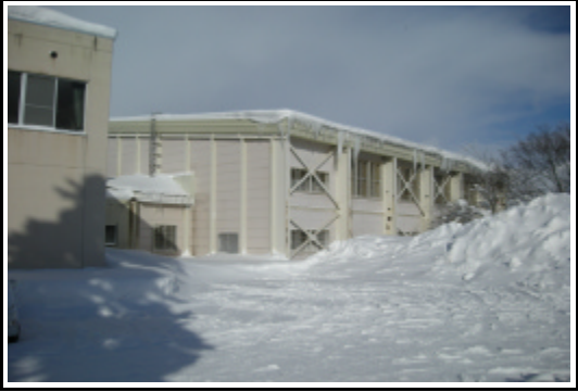
⑭から撮影した写真（敷地内）
