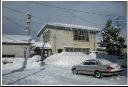
②から撮影した写真（敷地周辺）
