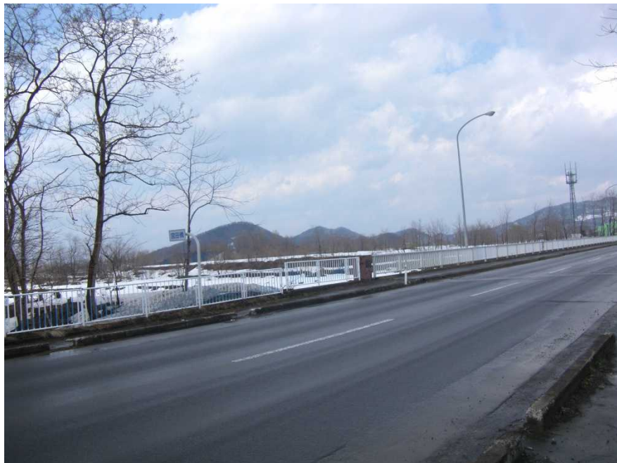
⑦左岸から右岸を望む（残雪期）
