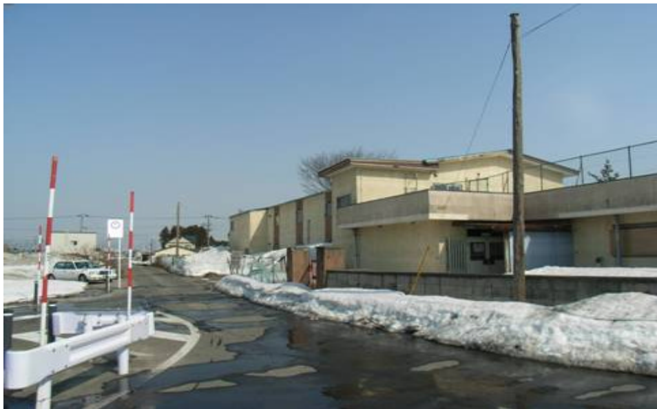
北西方向より
