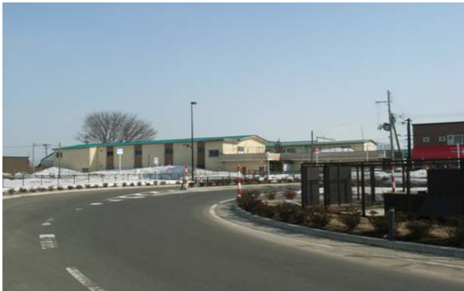
北西方向より
