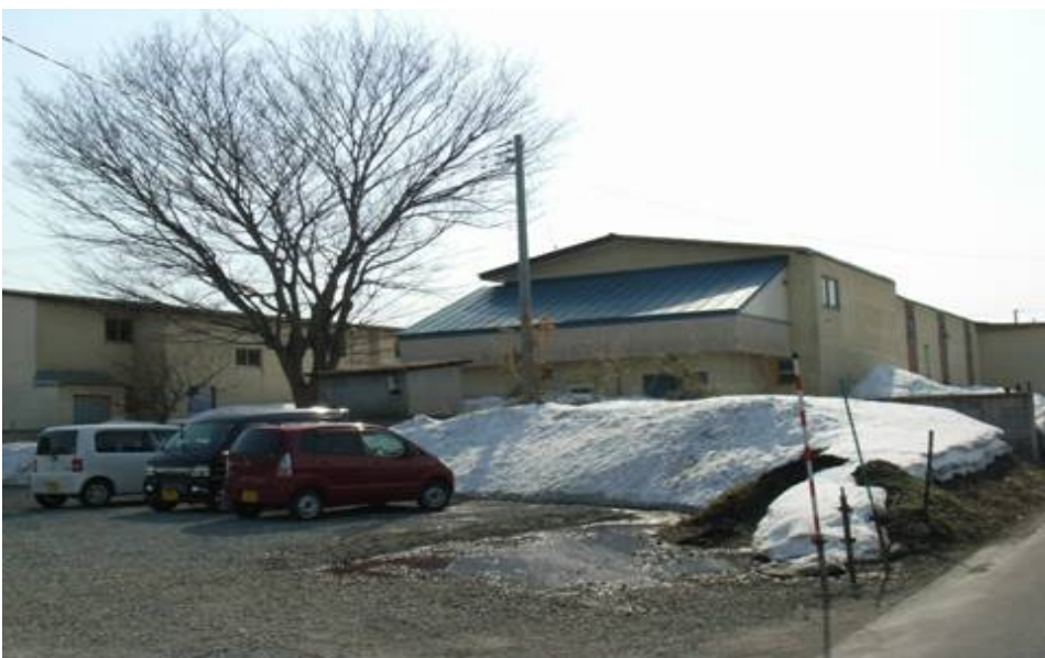
北東方向より
