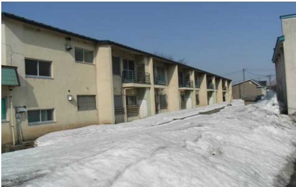
南西方向より
