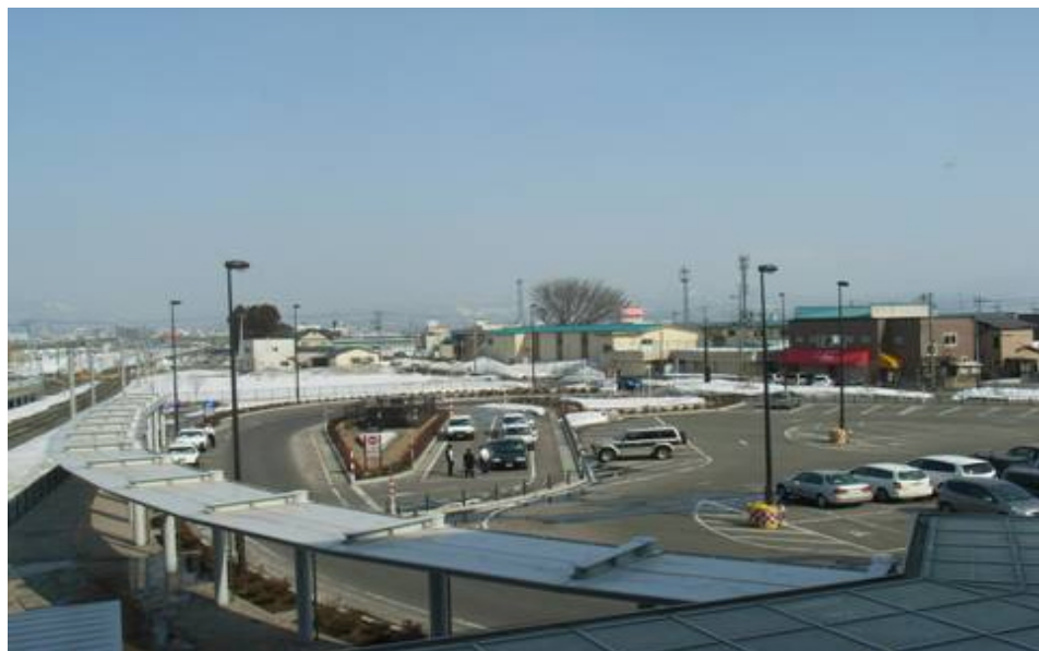
新青森駅舎内より
