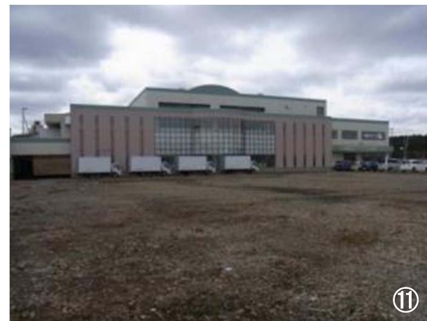
中学校給食センター(北西面)
