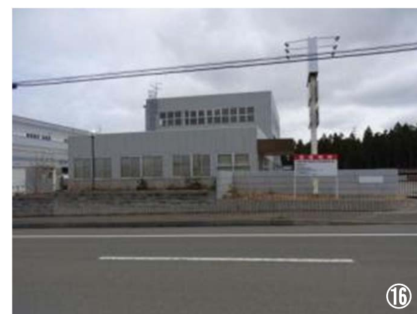
計画地より北東面を見る
