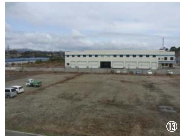
計画地から北西面を見る
