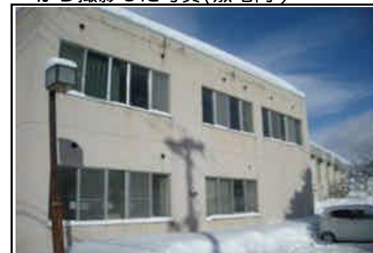
から撮影した写真（敷地内）
