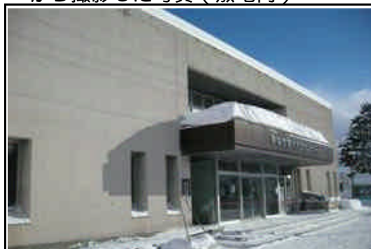
から撮影した写真（敷地内）
