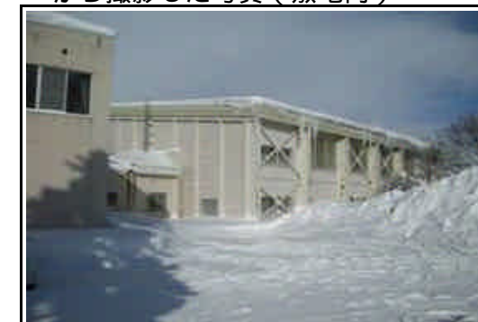
から撮影した写真（敷地内）
