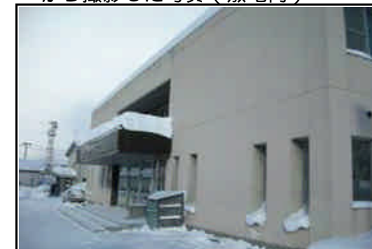
から撮影した写真（敷地内）
