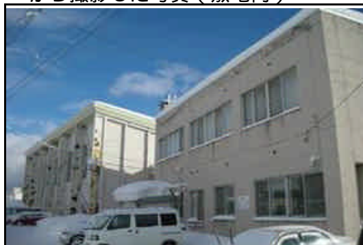
から撮影した写真（敷地内）
