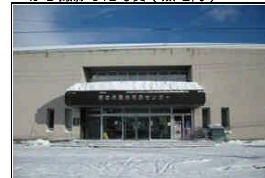
から撮影した写真（敷地内）
