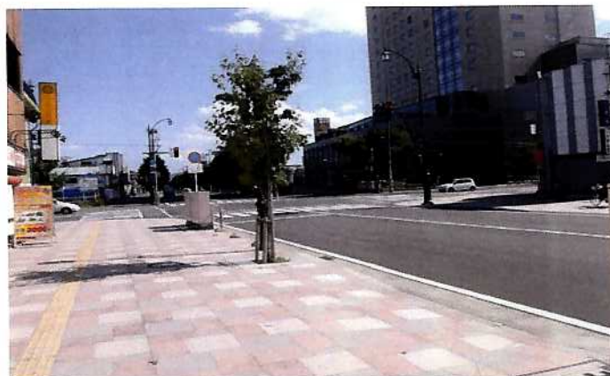
市道 うとう橋通り線舗装状況
