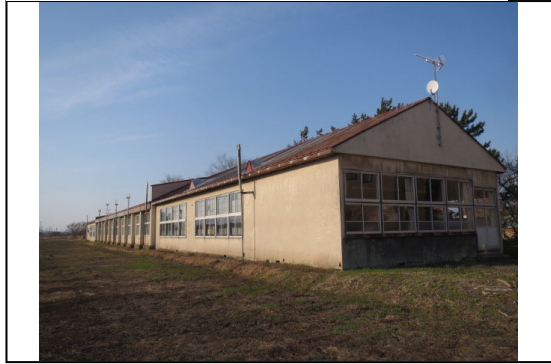
⑪から撮影した写真
