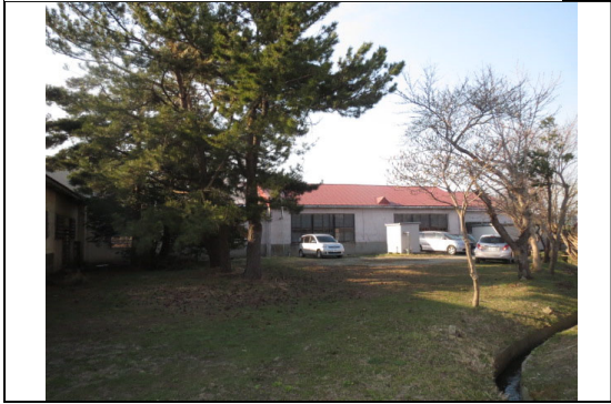
⑧から撮影した写真
