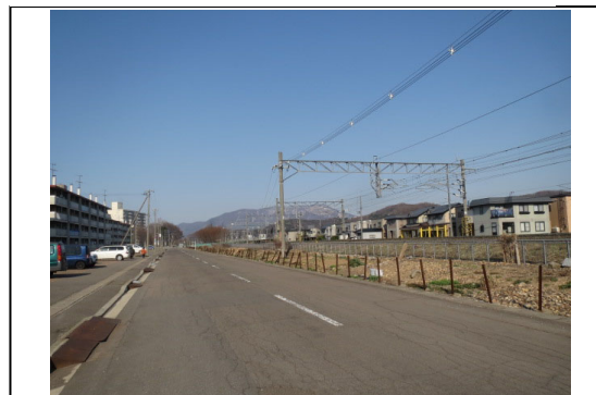
⑪から撮影した写真
