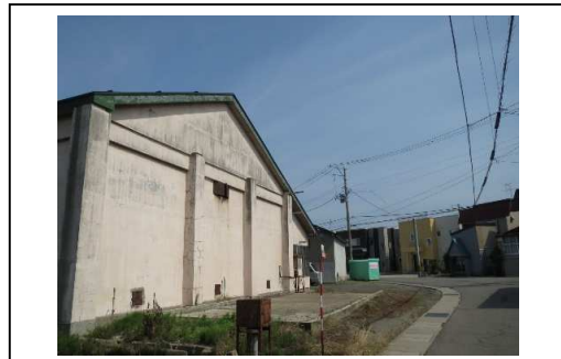
⑫から撮影した写真
