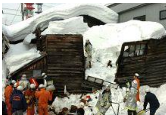
図 81 雪の重みで倒壊した家屋
