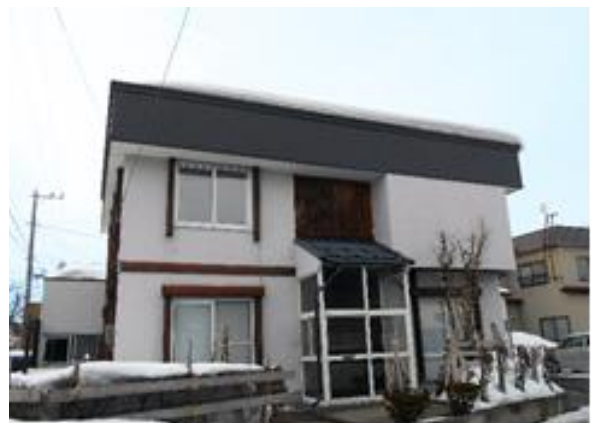
図 69 住宅（無落雪屋根への改修後）
