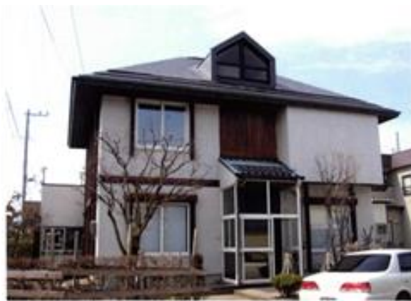
図 68 住宅（無落雪屋根への改修前）
