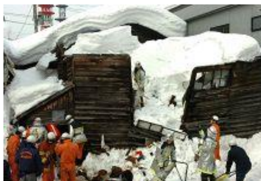
図 25 雪の重みで倒壊した家屋
