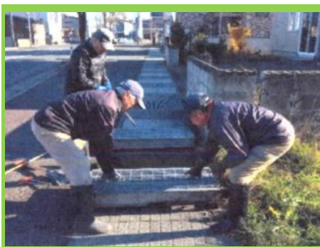
融雪溝水路の泥上げ/矢作町会
