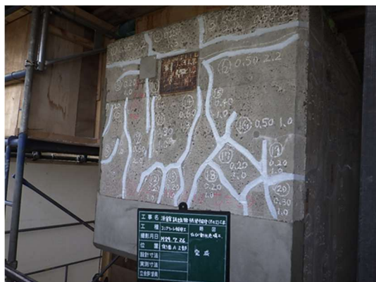
ひびわれ補修工例
