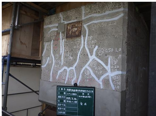
ひびわれ補修工例
