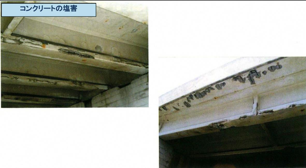
＜コンクリート表面の変色や鋼材に沿ったひび割れが見られる＞
