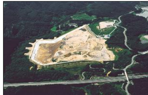
青森市一般廃棄物最終処分場
