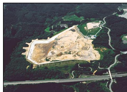
青森市一般廃棄物最終処分場
