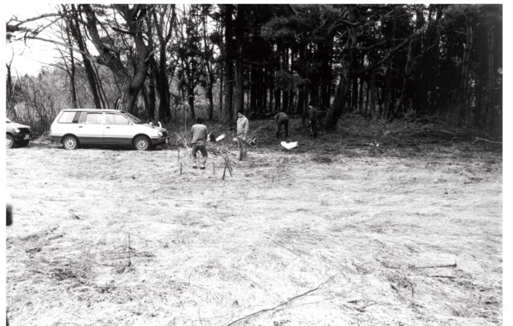
写真4 ボーリング調査の様子(平成元年)
