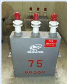
電力用コンデンサー
