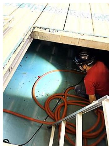
床下に潜る清掃作業員
