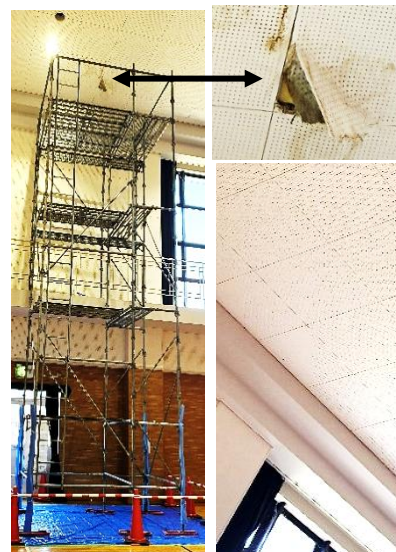
修復前の天井の穴(左と右上)、傷跡が分からない修復後の天井(右下)
