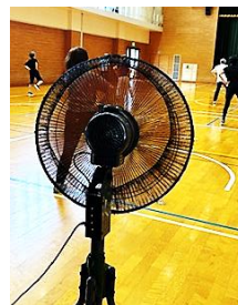
ロビーの冷気を取り込み(右)利用者へ送る大型扇風機
