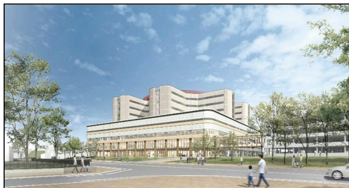
①東側市道からの病院正面全景
