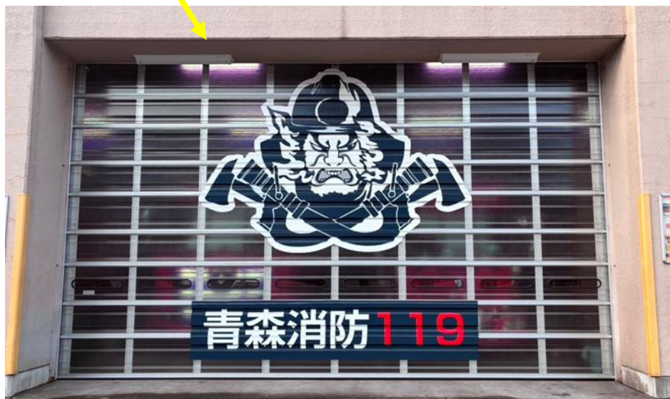
消防合同庁舎の新シャッター
