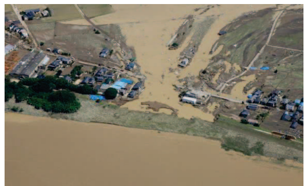
堤防決壊による家屋の流失(鬼怒川)
