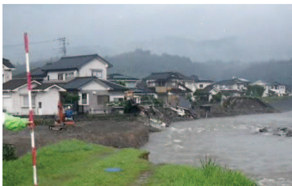
河岸侵食による家屋の倒壊(花月川)
