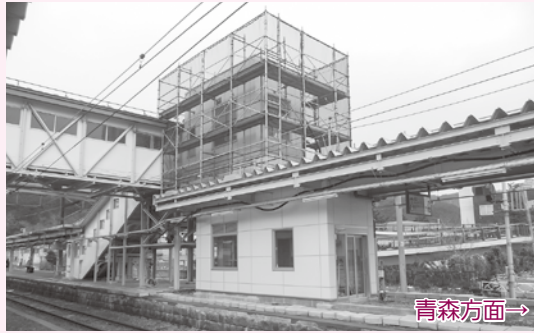
▲島式ホーム側エレベーター(令和6年2月15日時点)
