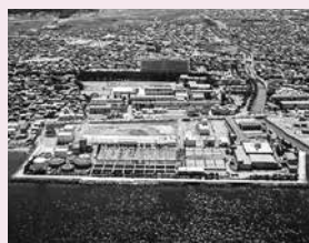
▲八重田浄化センター
