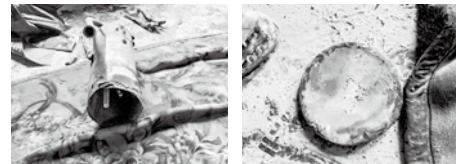
製造後32年経過。点検は未実施で、消火器は腐食していた。
