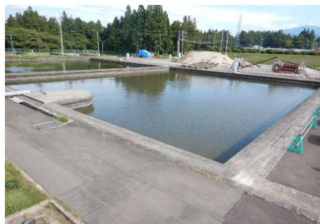
北系ろ過池（左端1号池、中央2号池）
