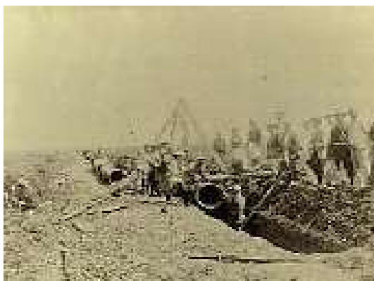
創設時の配水管の布設
