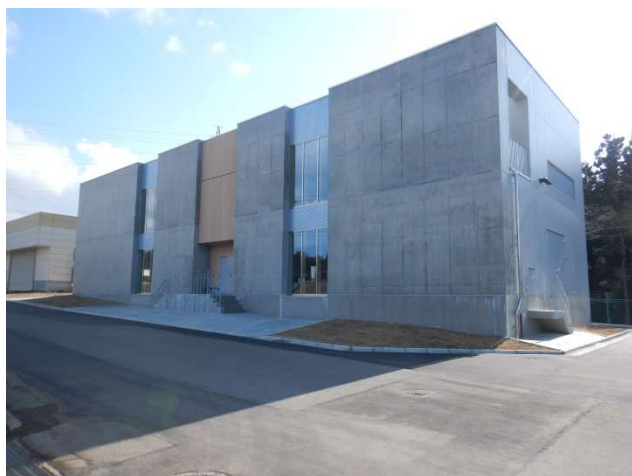
横内浄水場 紫外線・塩素処理棟
