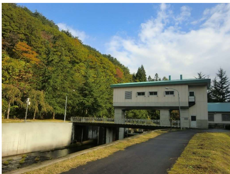
横内浄水場水源地 (取水施設)
