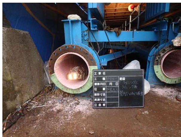
水管橋の更生工事
