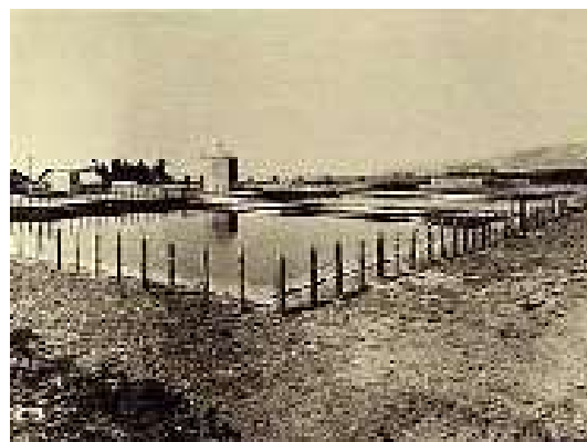
大正時代の横内浄水場
