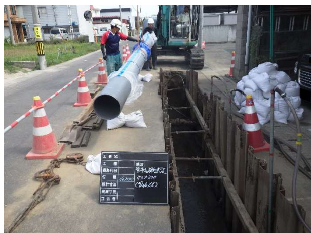
管路の耐震化工事
