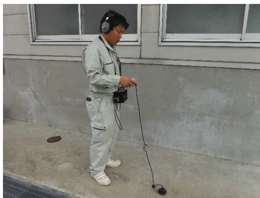
漏水探知機による漏水調査
